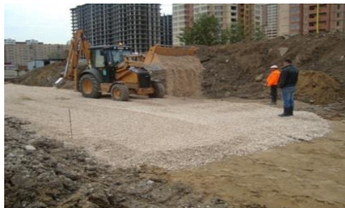
1. Ремонт дворовых проездов
